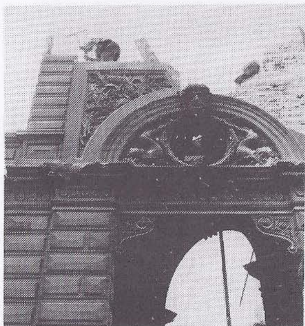
Eén van de toegangspoorten tot de Galerij tijdens de afbraak.
