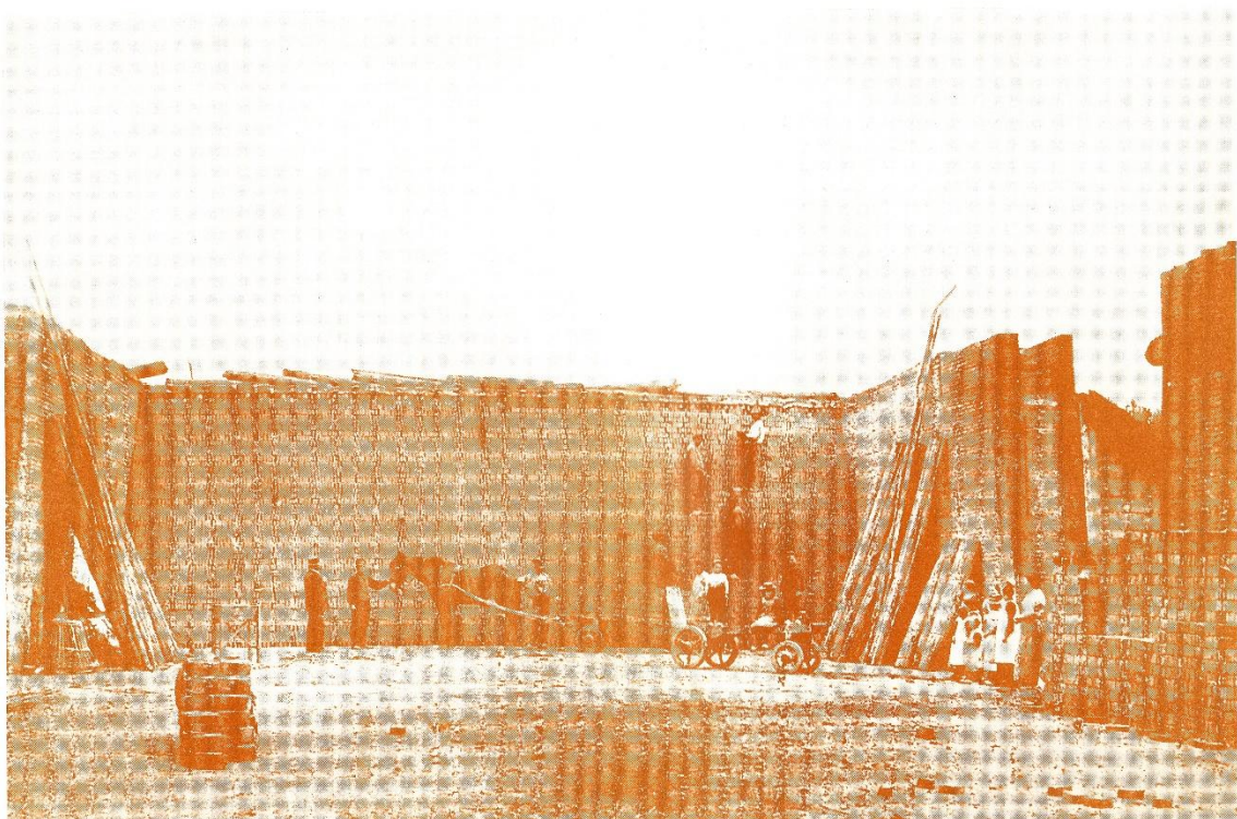
Het bakken van de stenen in de oude veldoven, met hout en turf gestookt...
